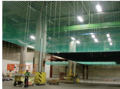
Postzentrum Basel (BS) Netzdecke / Plafond en filet / Net ceiling
