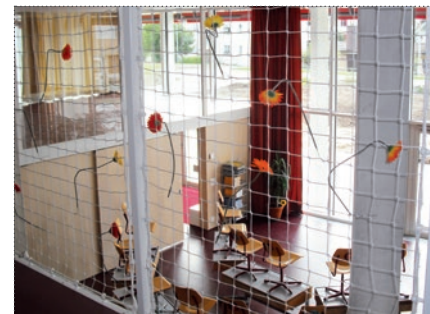
Grundschule Brügg (BE) Galerieschutznetze / Filets de protection pour galeries / Avalanche screen protection nets
