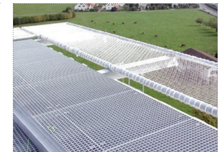
Spital Linth, Rega Landeplatz (GL) Helikopter Plattformnetze / Filets pour plate-forme d'hélicoptères / Helicopter platform nets
